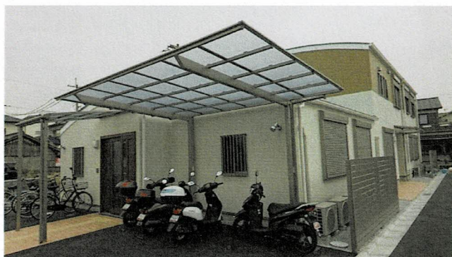
事務所建物全体
